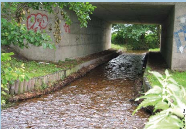
Eine raue Kiessohle und beidseitige Bermen verbessern die Passage für Wasser- und Landorganismen unter einer Brücke
