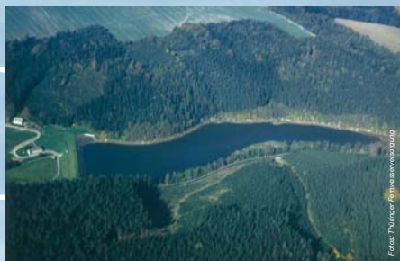
Talsperre Krebsbach vor dem Rückbau
