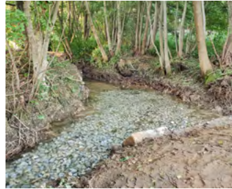
Das aufgelassene Wasserwiesenwehr Döb_5 vor (links) und nach Durchführung der Maßnahme (rechts). Die beiden Abstürze sind verschwunden, ebenso die nicht mehr benötigten Wehrmauern. Das Ufer wurde mit Sandsteinquadern aus den Wehrmauern etwas befestigt; es ist allerdings nicht zu erwarten, dass die Döberten großflächig ausufern wird. Die Döberten ist nun in allen gezeigten Bereichen wieder für Gewässerorganismen frei durchwanderbar.
