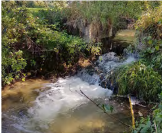
Das aufgelassene Wasserwiesenwehr Döb_4 vor (links) und nach Durchführung der Maßnahme (rechts). Der Absturz ist verschwunden, ebenso die nicht mehr benötigten Wehrmauern.
