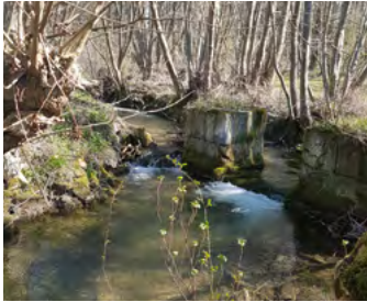
Das aufgelassene Wasserwiesenwehr Döb_5 vor (links) und nach Durchführung der Maßnahme (rechts). Die beiden Abstürze sind verschwunden, ebenso die nicht mehr benötigten Wehrmauern. Das Ufer wurde mit Sandsteinquadern aus den Wehrmauern etwas befestigt; es ist allerdings nicht zu erwarten, dass die Döberten großflächig ausufern wird. Die Döberten ist nun in allen gezeigten Bereichen wieder für Gewässerorganismen frei durchwanderbar.
