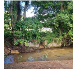
Das aufgelassene Wehr in der Krassach im Abschnitt 13 vor (links) und nach Durchführung der Maßnahme (rechts). Bei Beginn der Maßnahme im September 2025 wurde festgestellt, dass der noch im Frühjahr 2025 vorhandene, ca. 30 cm hohe Absturz seltsamerweise verschwunden war. Deshalb wurde beschlossen, die in Fließrichtung rechtsseitige, bereits instabile Wehrmauer vollständig zu entfernen und die beiden Mauern auf der anderen Bachseite zu belassen. Der Absturz ist verschwunden, ebenso die nicht mehr benötigte Wehrmauer. Ins Ufer wurde eine Totholzwurzel gedrückt, um Strömungsvielfalt zu schaffen. Die Krassach ist nun in diesem Bereich wieder für Gewässerorganismen frei durchwanderbar.
