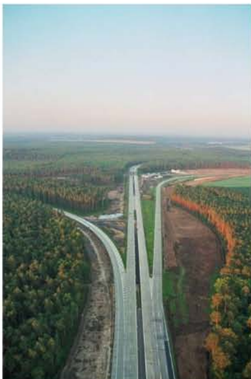
Foto: Luftaufnahme der Baustelle Dreieck Nuthetal, aufgenommen von Rüdiger Herzog
