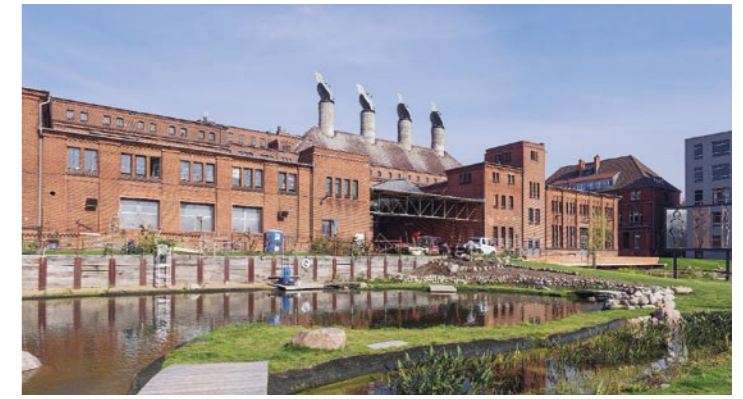
Durch Dachbegrünung und künstliche Wasserflächen auf dem Gelände der IGG Malzfabrik in Schöneberg erfolgt nicht nur die Retention von Regenwasser – das Wasser kann auch als Betriebswasser verwendet werden.
