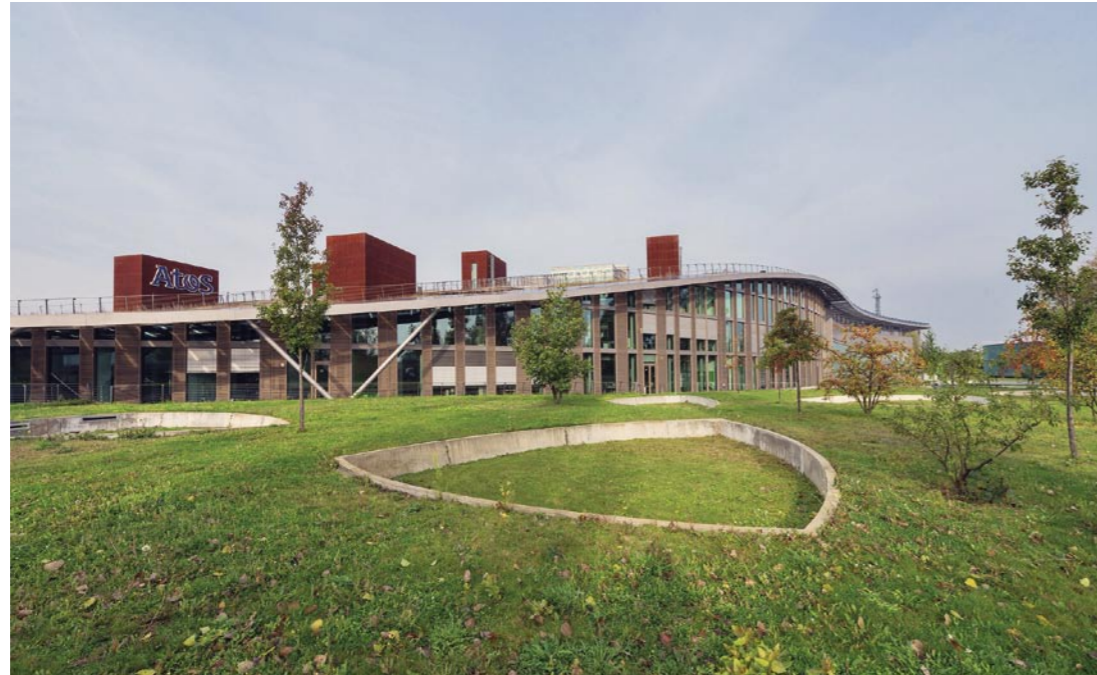
Das ehemalige Solon-Gelände in Adlershof. Dachbegrünung, Teiche und Rigolen halten das Regenwasser komplett auf dem Grundstück zurück.
