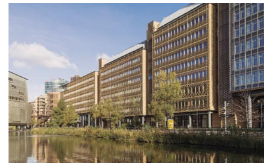
Zur Entlastung des Landwehrkanals setzt das ökologische Gesamtkonzept am Potsdamer Platz auf eine Kombination von Dachbegrünung und Teichen zur Verdunstung, sowie auf Regenwasserspeicher zur Nutzung als Betriebswasser.
