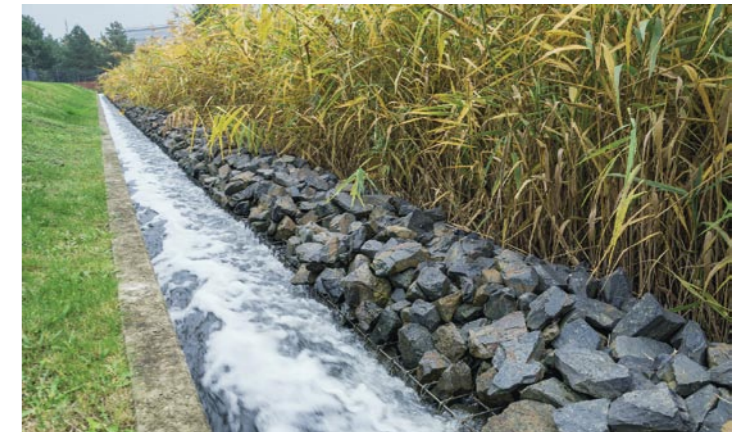
Der Retentionsbodenfilter mit Regenklärbecken in Adlershof entlastet den Teltowkanal, indem er das gereinigte Regenwasser zeitverzögert in das Gewässer einleitet.
