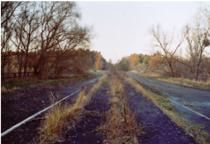
Bild: Marode Autobahnbrücke Teltowkanal. (c) Rüdiger Herzog
